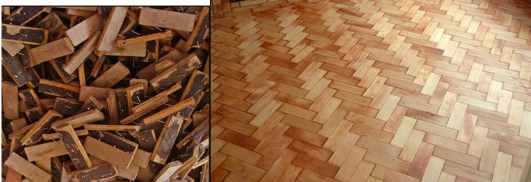
O piso de madeira é retirado de um cômodo de uma casa e reinstalado em outro.
